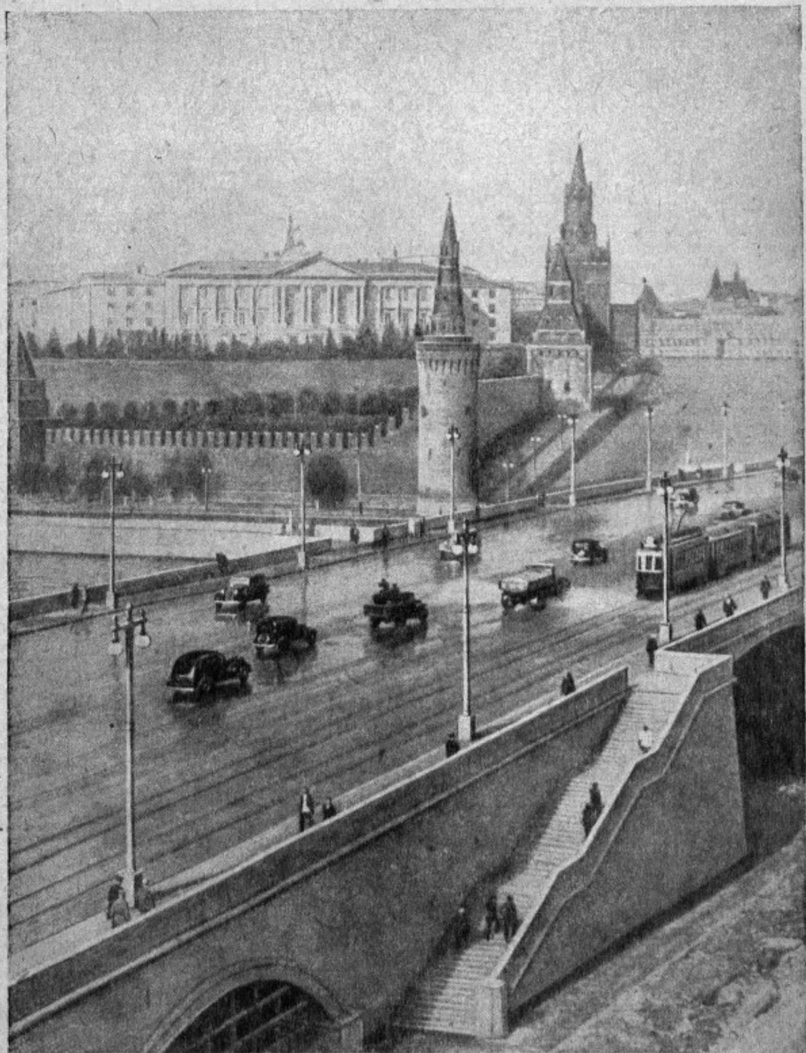
В результате осуществления генерального плана реконструкции Москвы с каждым годом преобразается столица Советского Союза. Расширяются магистрали, строятся новые мосты, одеваются в гранит набережные. На снимке — новый Замоскворецкий мост через Москва-реку. Трамвай не стесняет движения автотранспорта.
